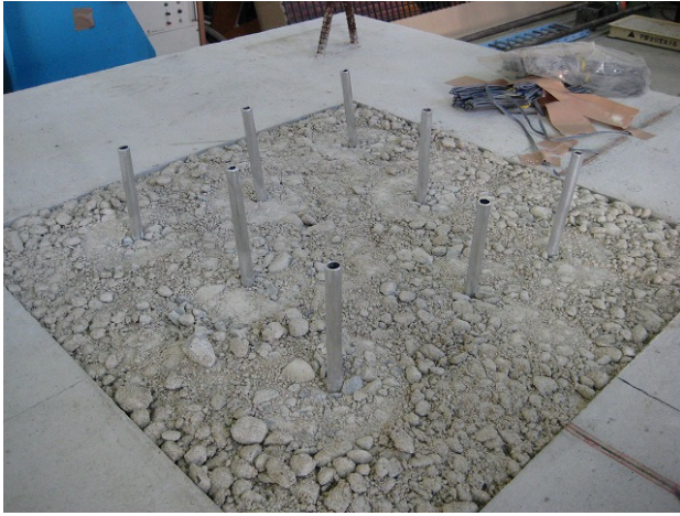
写真-1 補修床版（劣化部へのパイプ打込み直後）
