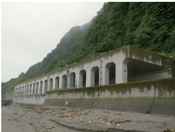
写真-1 RC製ロックシェッドの一例
