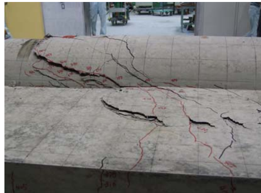
写真-1 BW2-1破壊状況(壁部上側)
