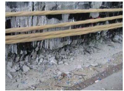
写真-2 スtrandシートの破断 (Case3)
