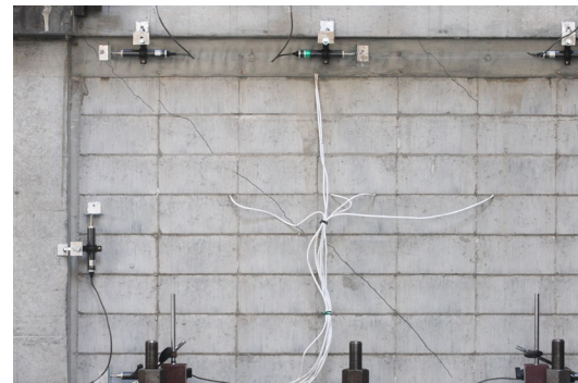
(a) 既存RC壁側
