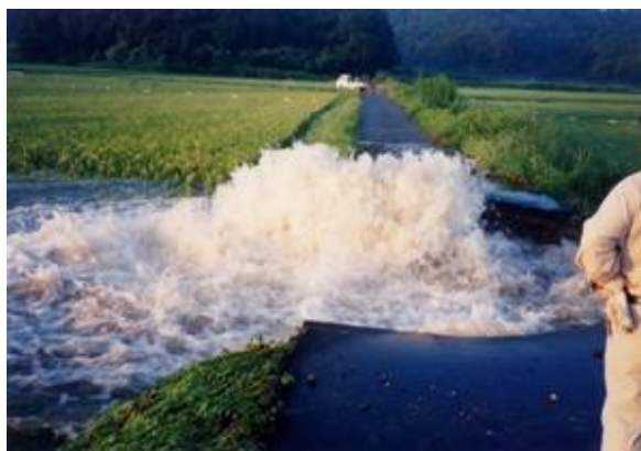
写真-1 漏水事故状況
