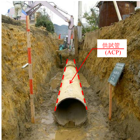
写真-2 供試管採取状況
