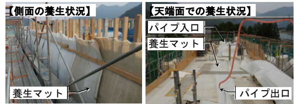
図-4 保温養生の実施状況
