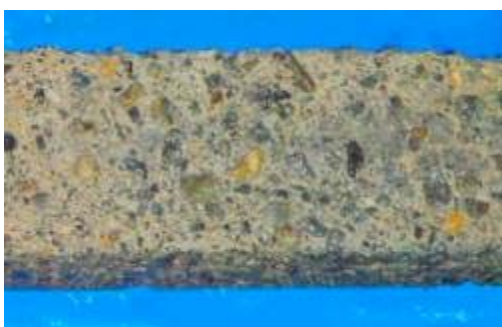
写真-1 凍結融解繰返し終了後の複合劣化供試体
