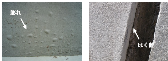
有機系被覆材の付着性低下
