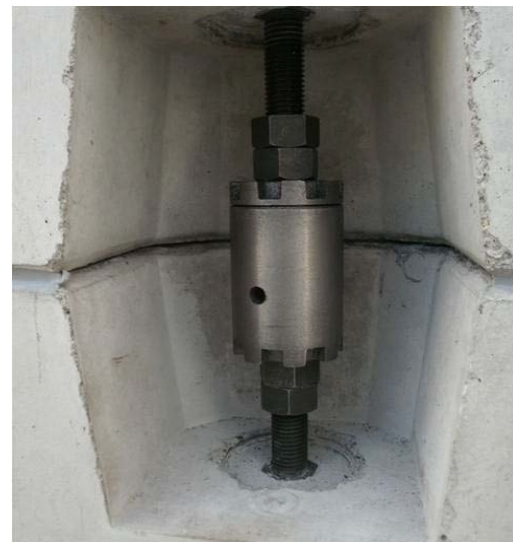
写真-1 機械式継手によるジョイント
