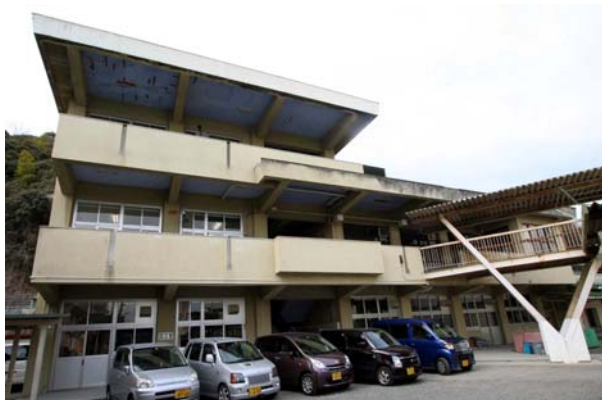
写真-1 建物外観（改修前）
