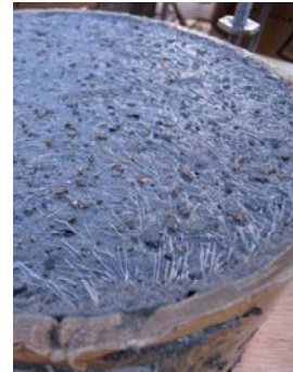
写真-2 UFC の薄層除去後の状況（No.2 試験体）
