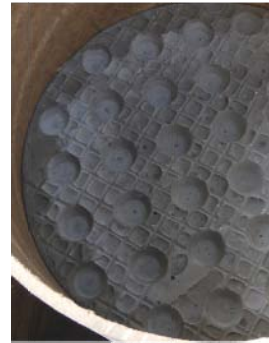
写真-1 せん断キーの成形状況（水平打継）（No.1 試験体）
