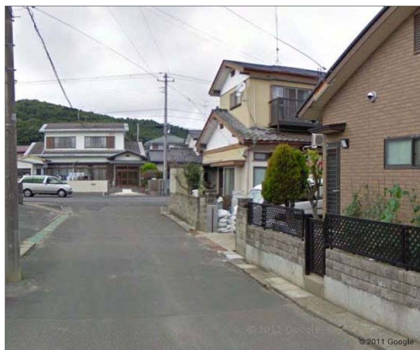
写真-2 乾燥時の道路の様子 6)
