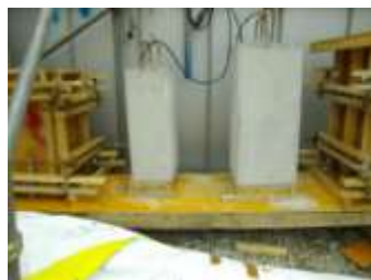
写真-2 打設後の様子
