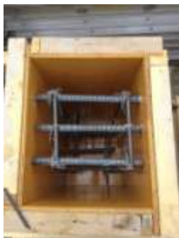
写真-1 打設前の様子
