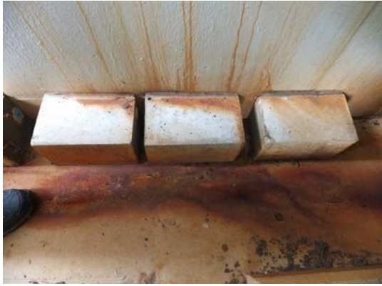
写真-1 曝露供試体設置状況 (A橋)
