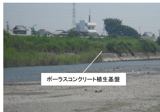
写真-1 ポーラスコンクリートを護岸整備に使用した時の植物の繁茂例
