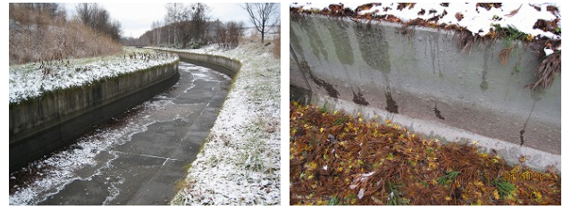
融雪水に曝される開水路 融雪水に曝される被覆工法 図-2 積雪寒冷地に位置するコンクリート開水路の非灌漑期の状況
