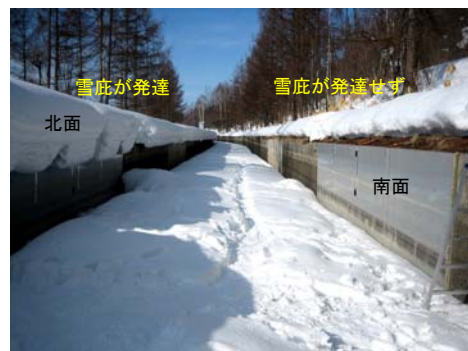
写真-4 冬期間の試験施工区間の状況
