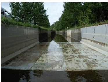
写真-3 施工後の状況 (灌漑期間 1 回終了時)
