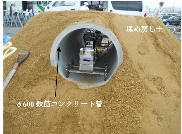
図-8 管の埋設状況
