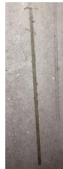
写真-5 けがきを用いたガイド
