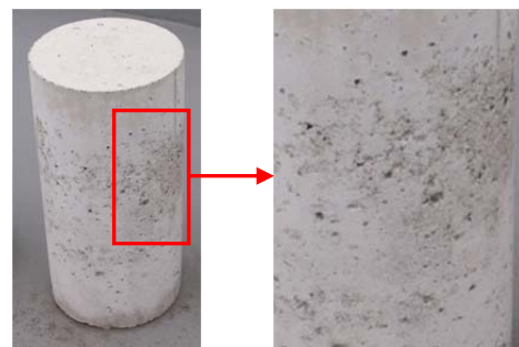
図-1 高炉スラグ微粉末-Na 2 CO 3 系コンクリートの表面の変状
