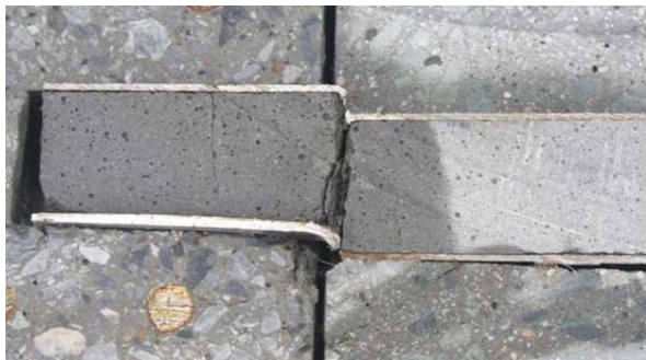
(b) ずれ止めのせん断破壊
