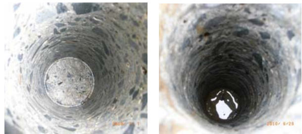
(a)コア穿孔のみの内面 (b)全面目荒し後の内面
