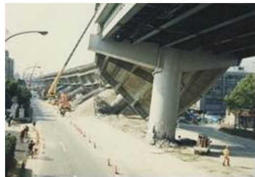
写真-1 阪神高速道路神戸線 125 番 RC 橋脚
