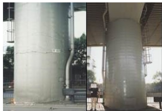
写真-2 阪神高速道路神戸線 62 番 RC 橋脚
