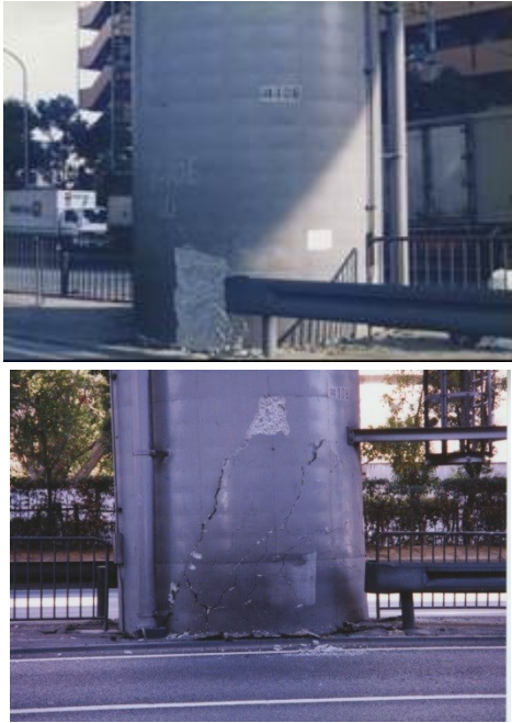
写真-3 阪神高速道路神戸線 106 番 RC 橋脚
