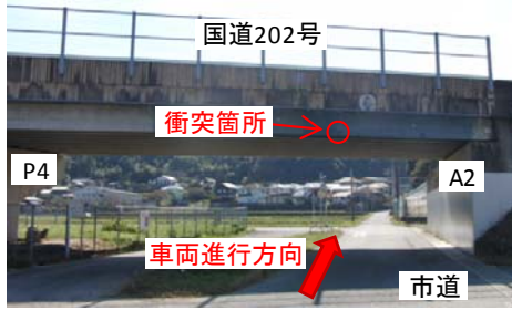
写真-1 G10 桁側からの橋梁、交差道路の状況
