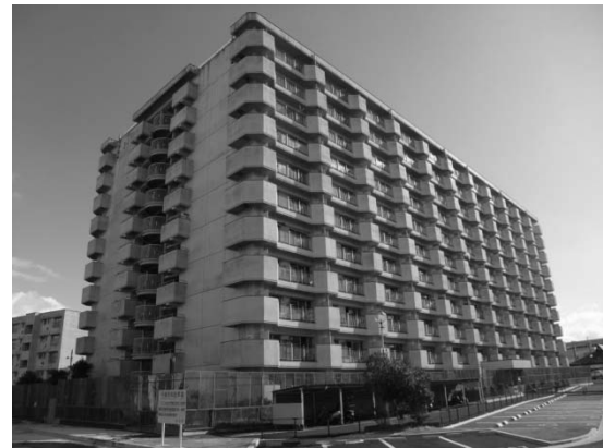
図-2 対象建物外観
