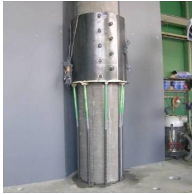
写真-7 鋼板接合後
