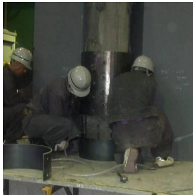
写真-10 鋼板接合状況
