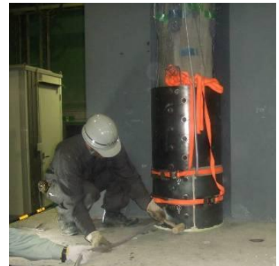
写真-11 モルタル充填状況
