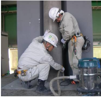
写真-6 削孔状況
