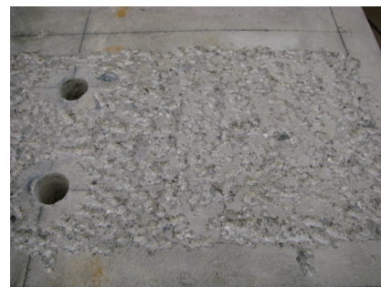
写真一 接合部試験体の目荒らしの状況
