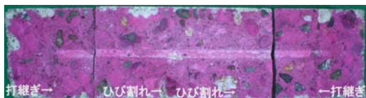
写真-10 N-0.1mmにおける11年暴露試験体の状況
