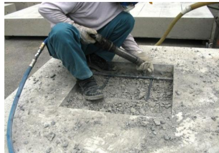
写真-2 ブレーカ等によるハツリ処理
