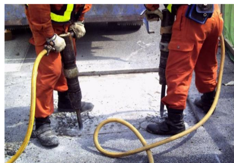
写真-1 ブレーカ等によるハツリ処理
