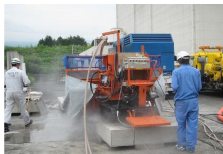
写真-4 WJ によるハツリ処理
