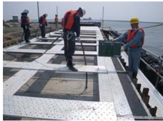
写真-1 型枠内での締固め状況
