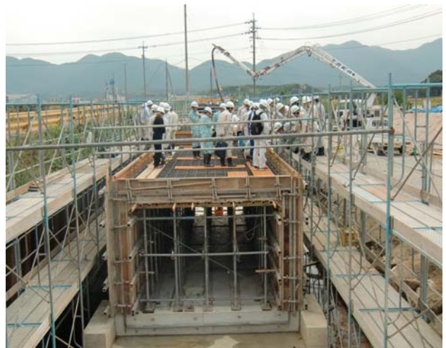
写真-2 施工状況把握研修の状況(1)
