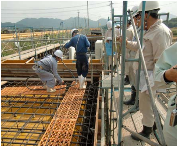
写真-3 施工状況把握研修の状況(2)
