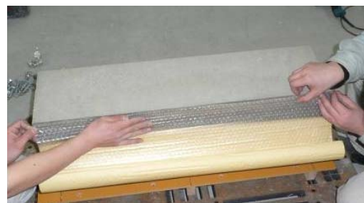
写真-1 貼付型保水・保温養生シート貼り付け状況
