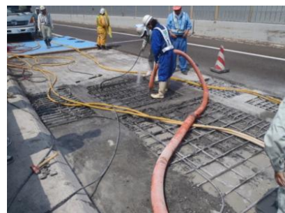
写真-1 ウォータージェットによるはつり
