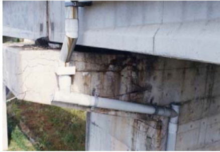
(2) RC 橋脚 (B 橋) の梁部
