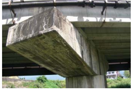
(3) PC 橋脚 (C 橋) の梁部
