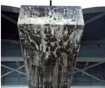
(1) RC 橋脚 (A 橋) の梁部
