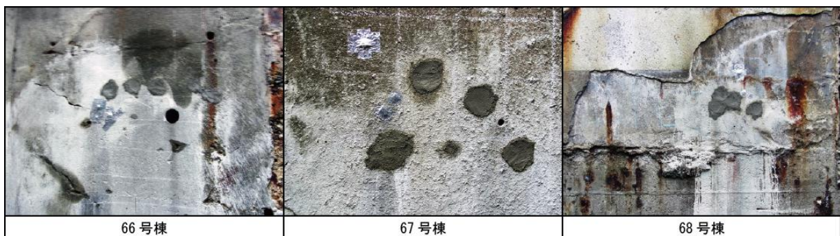
写真-1 各棟の外観状況
