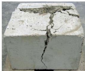
写真-1 縦割裂破壊
