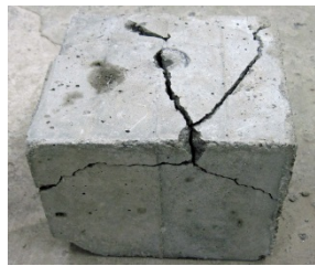
写真-2 表面割裂破壊
