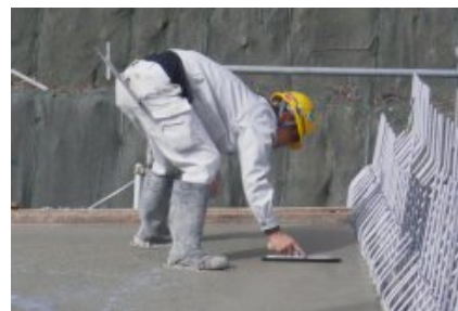
写真-1 天端均し状況
