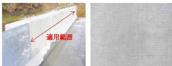
a. 排水・湿潤連続養生箇所 b. 表面近影 写真-6 脱型後のコンクリートの仕上がり状況
