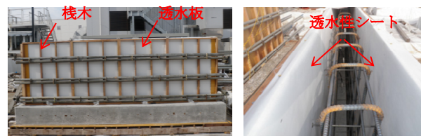
a. 型枠組立て状況
