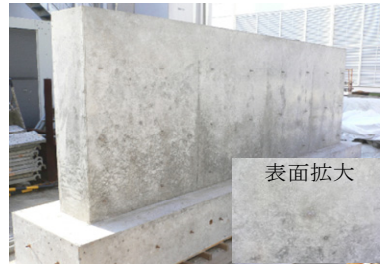
b. 木製型枠部材
