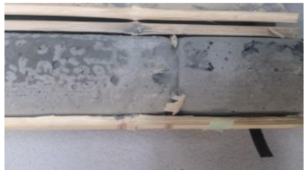
写真-3 残存隔壁破壊後 (写真2右端部の拡大)
