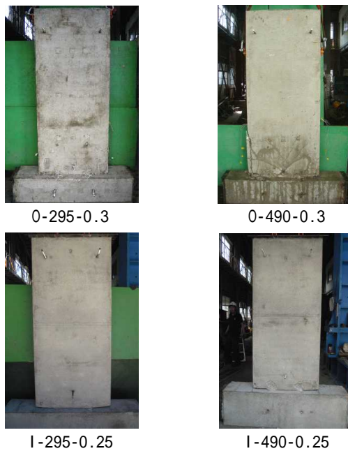
写真-1 実験後の損傷状況
