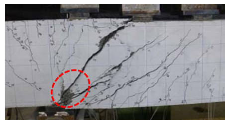
図-15 荷重試験における破壊時の損傷状況
