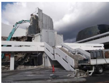
写真-1 市民ホール渡り廊下
