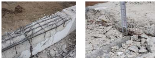
写真-7 試験体解体調査
