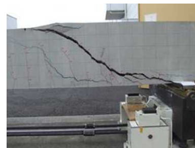
写真－１ 試験体損傷状況 (A-1)
