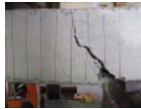
写真 - 7 最終破壊 状況 No.1
