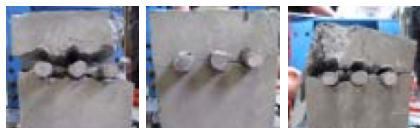
シリーズ2 主筋3本 ガラス繊維 無 写真 - 4 最終破壊状況 No.13 シリーズ2 主筋3本 補強法B 主筋抜け出し 写真 - 5 最終破壊状況 No.20 シリーズ2 主筋3本 補強法B GFRP剥離 写真 - 6 最終破壊状況 No.21
