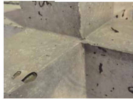
写真-12 HPFRCC+EPS有筋の破壊性状
