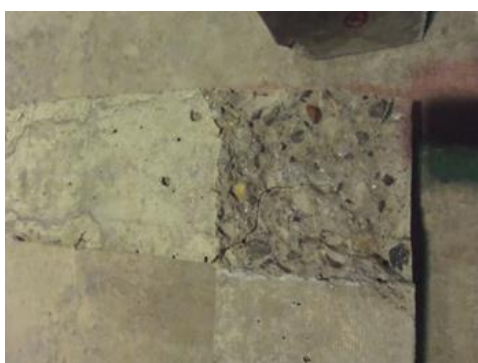
写真-8 三本足供試体①破壊性状
