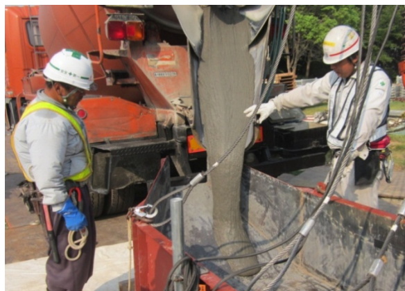
写真-2 アジテータトラックからの荷卸し状況
