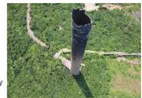
写真-1 大煙突の俯瞰
