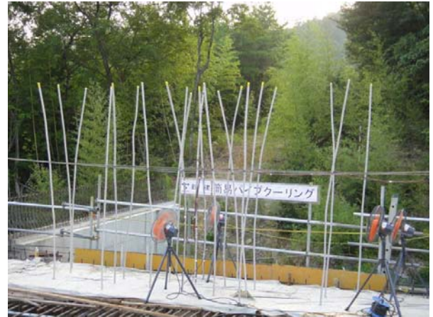
写真-1 ヒートパイプを利用したパイプクーリング状況
