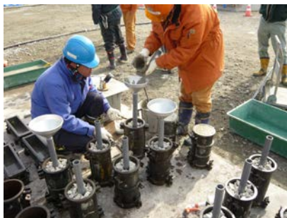
(a) プレパックドコンクリート
