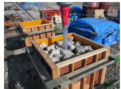
写真-3 ブロックの作製状況 (プレパックドコンクリート)
